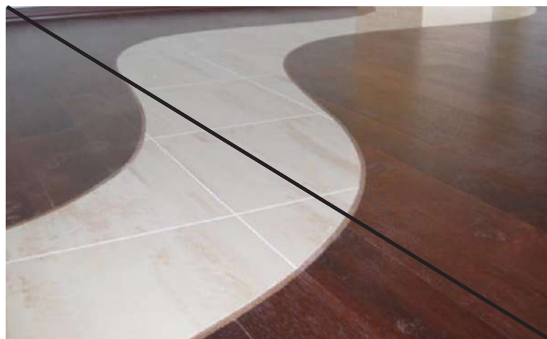
Плохо Узорные стыки из разных материалов
